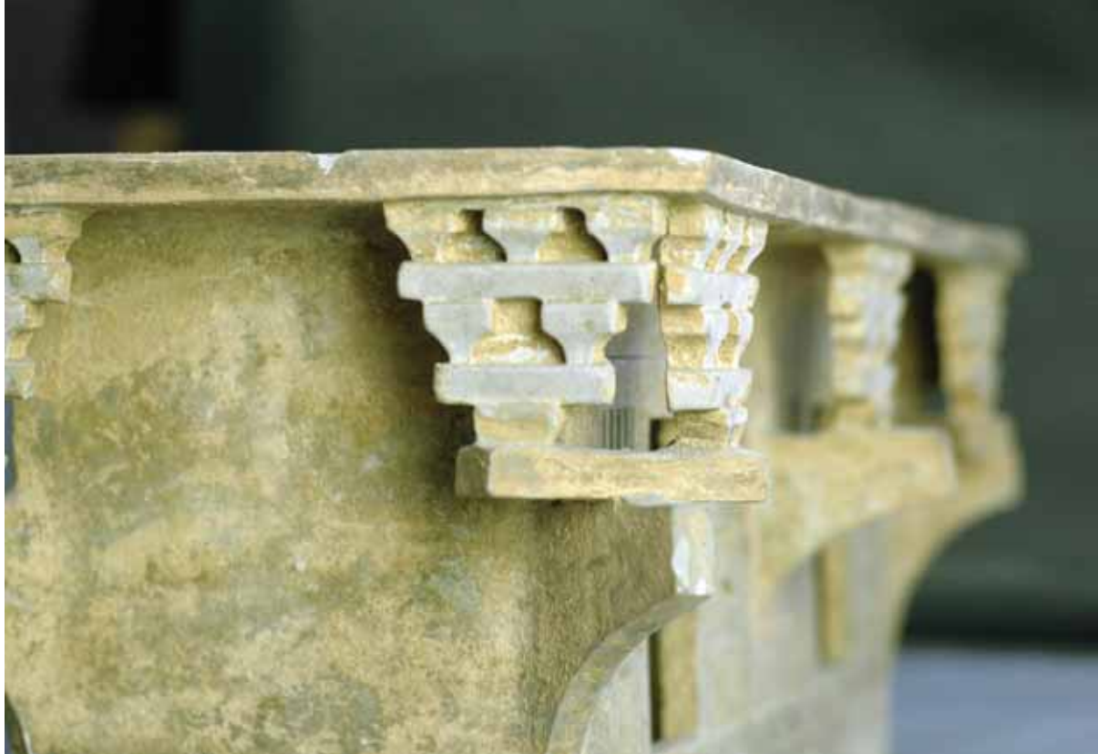
Detail van de plaatsing van korbelen.
